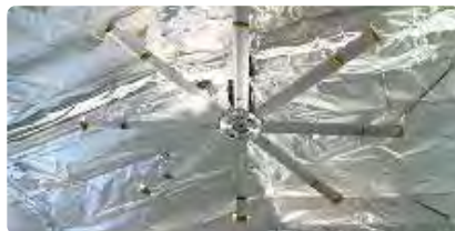
第一倉庫近年の気温上昇に伴い対策として遮熱シートと大型ファンの設置
