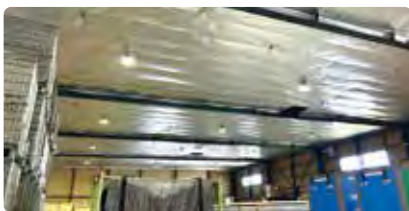
八田1号・2号倉庫 遮熱シートの設置
