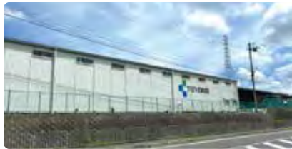
八田1号倉庫外壁改修
